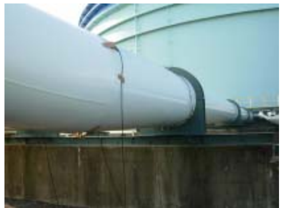
図 2 円筒面上における平面位置標定の精度評価を実施した国家石油備蓄基地における大型（34B-B9）配管
