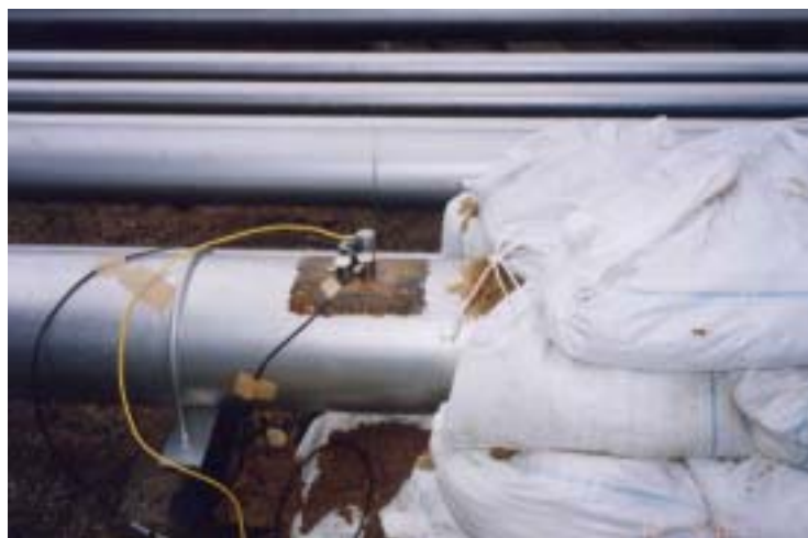
写真 2. 模擬埋設配管上に取り付けられた AE センサ
