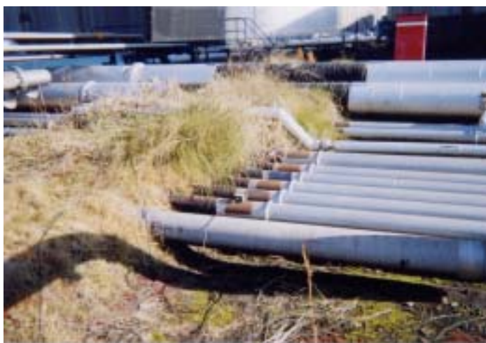
写真 3. AE 計測を実施した製油所の配管
